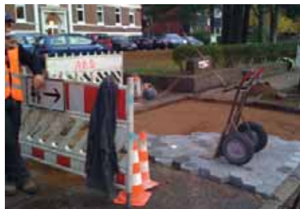
Inzwischen sind alle Einfahrten fertiggestellt.
